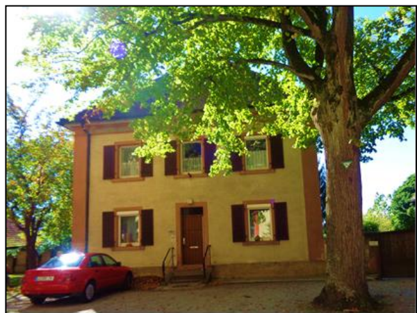
Die Kaplanei – die Außenstelle
